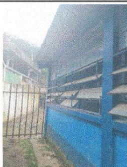
Foto 5: 5.5. Sustitución de vidrios
