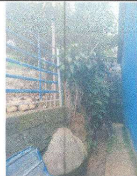
Foto 2: 15.1. Reparación de muro perimetral de block.
