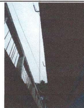
Foto 4: 7.2. Sustitución de canal de pvc
