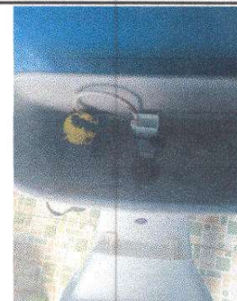
Foto 6: 10.2. Sustitución de accesorios inodoro (contra llave, tubo de abasto y tanque)
